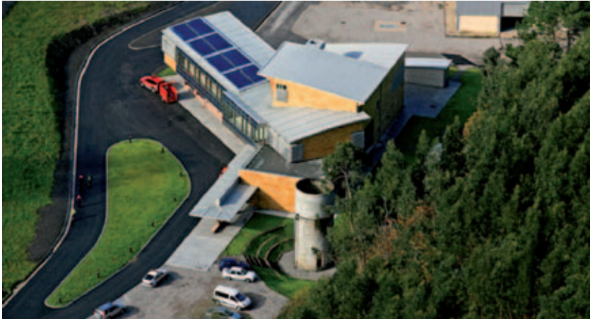
Centro de Investigación de fuegos y ventilación de túneles. San Pedro de Anes. Fundación Barredo. Edificio seleccionado en Asturias por PSE-ARFRISOL como C-Ddl.
